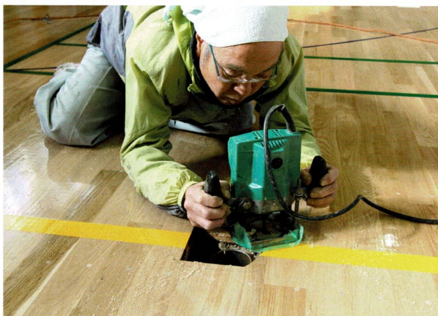
ルーターで溝切り。熟練の技巧が光ります
