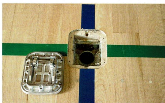
仕上がった床金具ホールとパネル
