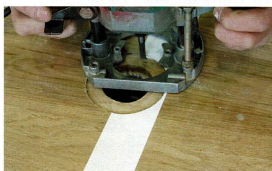
円柱ポールのパネルもぶれなく仕上げます
