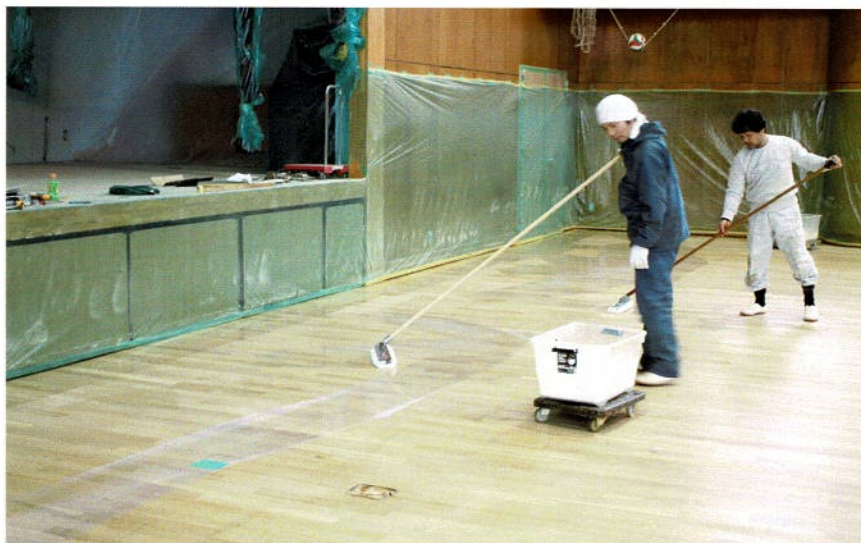
水性ポリウレタン樹脂塗料塗布は3回掛けます
