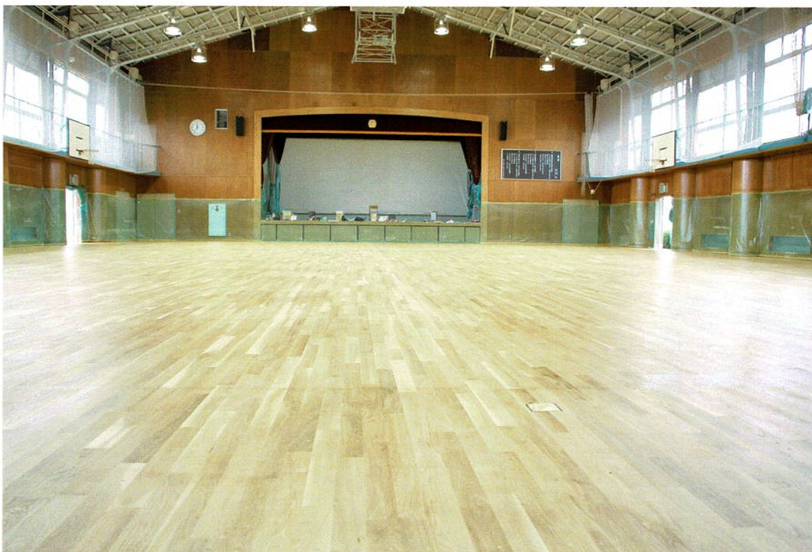
水性ポリウレタン樹脂塗料が乾燥硬化した体育館内。この後、コートライン引き作業に入ります
