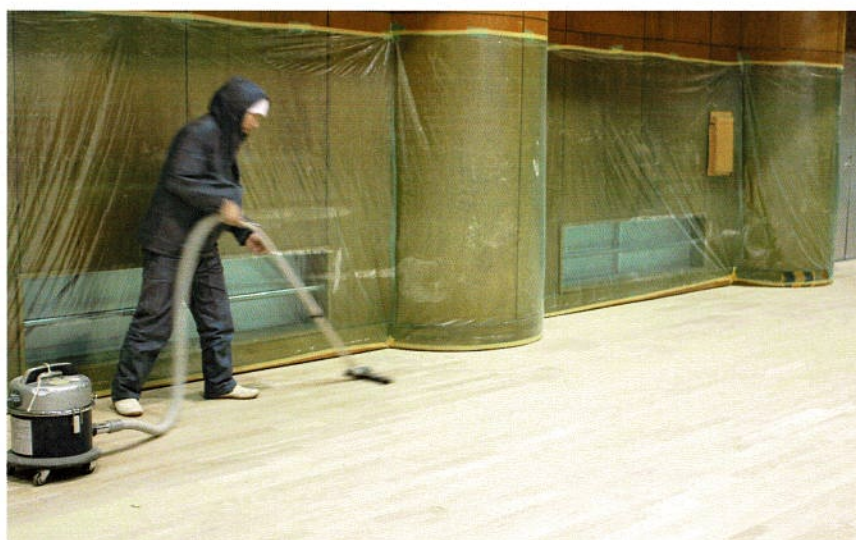
バフ磨き後、塗装前に入念な粉塵吸引除去
