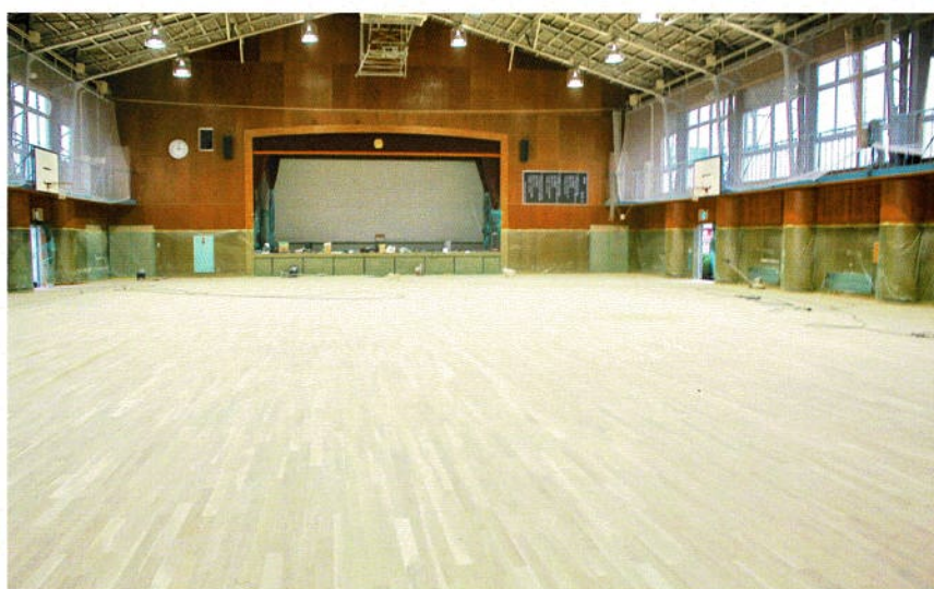
水性ポリウレタン樹脂塗料塗布前、粉塵吸引除去が終わったフローア
