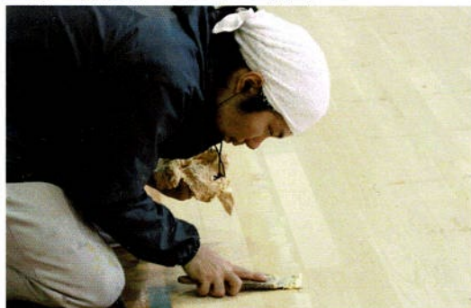
細部の間隙はウッドパテで処理
