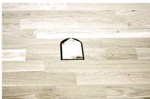
金具穴は仮駒を置いて研磨します
