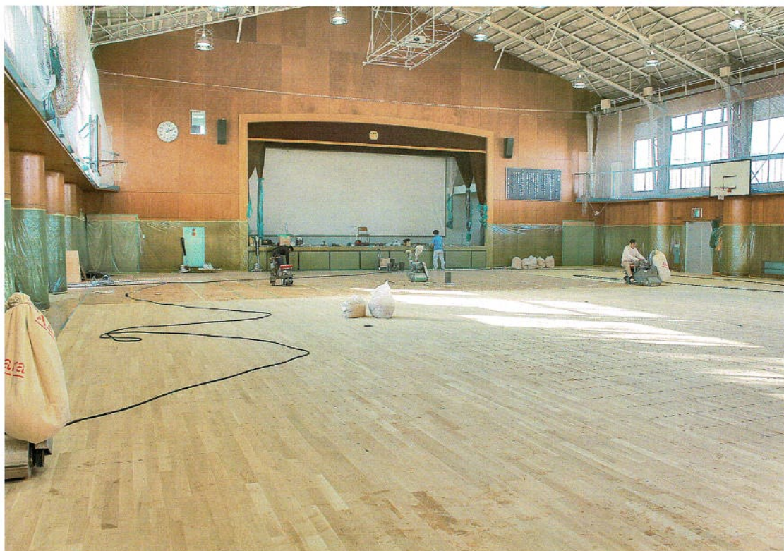
サンダー掛けで表面を0.1mm単位で研磨 この工程を3回繰り返します
