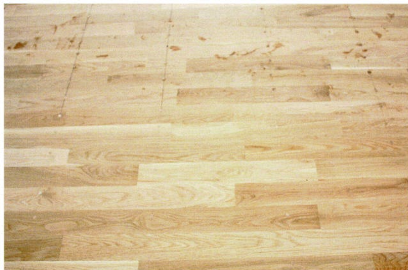
3回目の研磨終了、黒チョークが薄く研磨されているのが判ります
