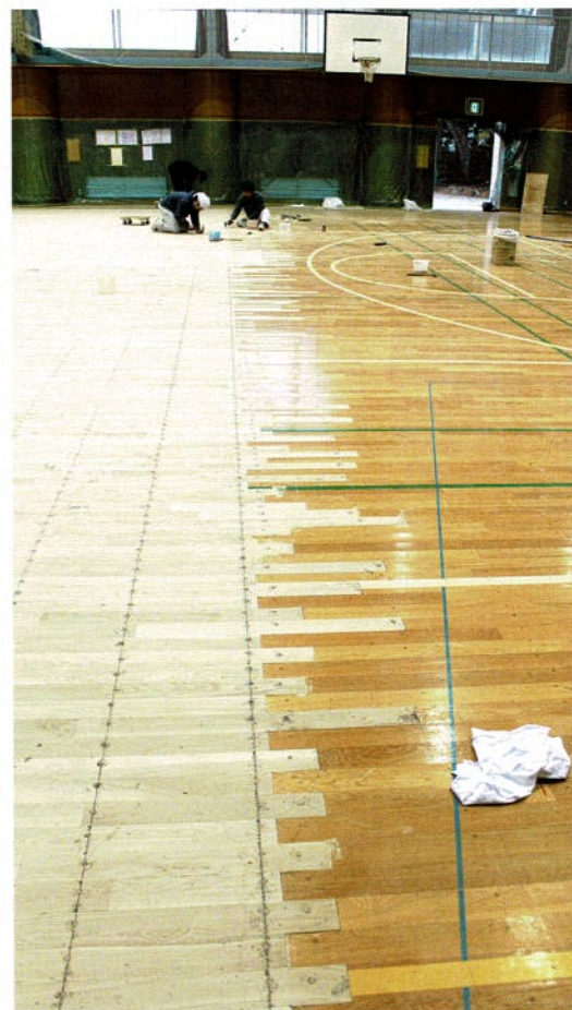
既存床との接合部
