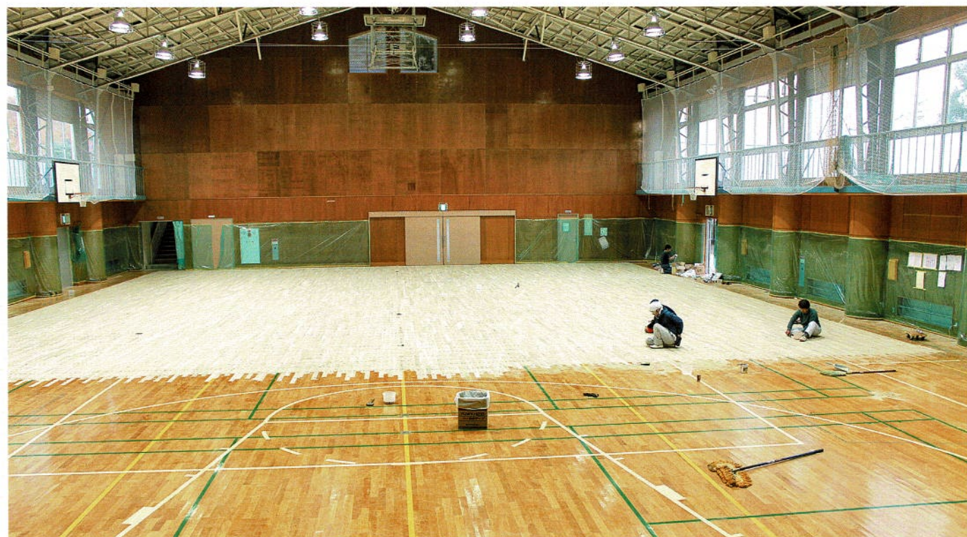
きれいに敷き詰められたフロア材
