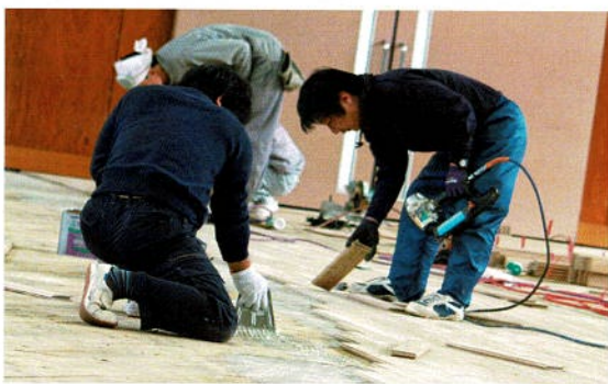
フロア材の敷き込みを進めます
