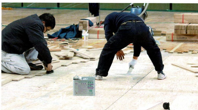
接着剤を塗布して直後に敷き込む連携作業
