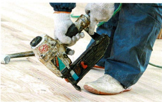
エアータッカーでフィニッシュネイル留め
