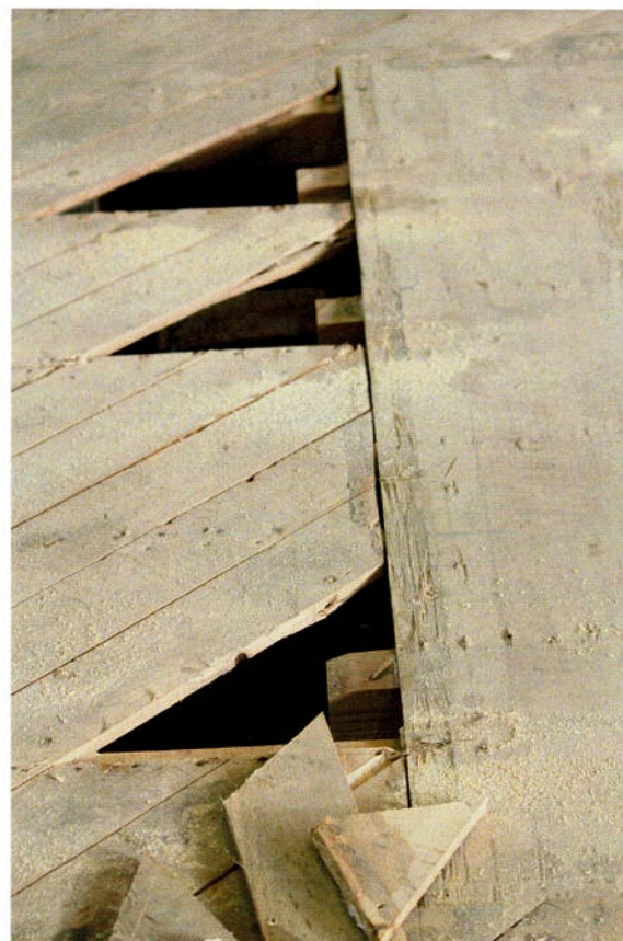
根太不足の箇所を確認
