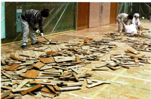
丁寧に剥離を進めます
