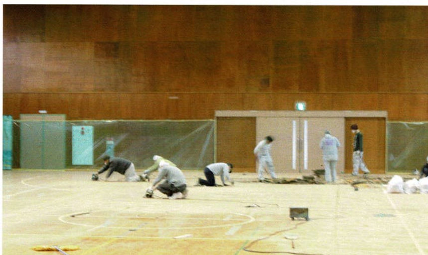
総掛かりの作業になります
