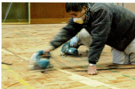
フロア床材の剥離に着手
