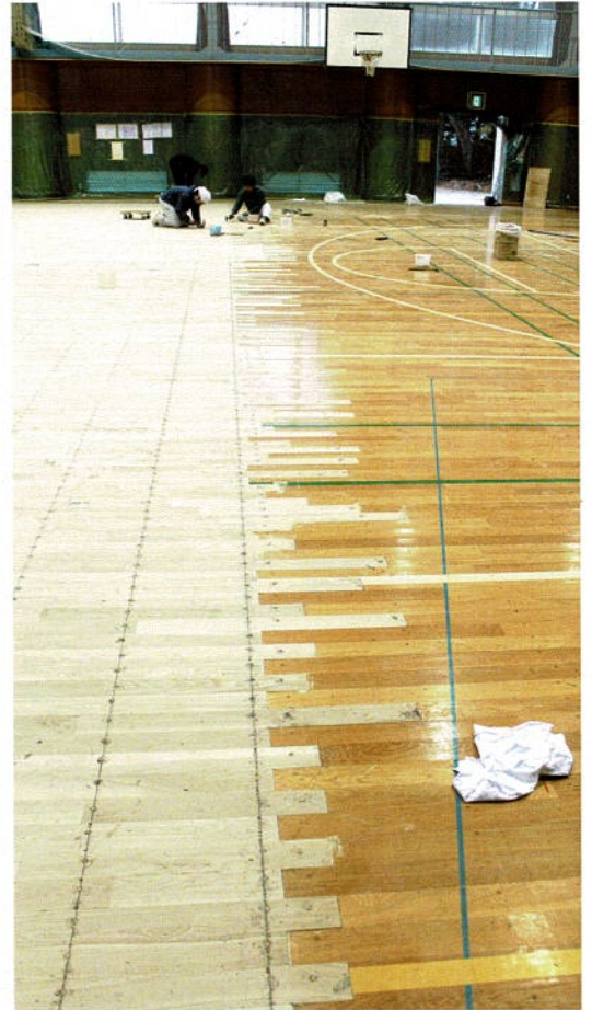
既存床との接合部
