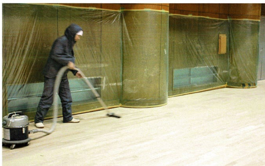
バフ磨き後、塗装前の入念な粉塵吸引除去
