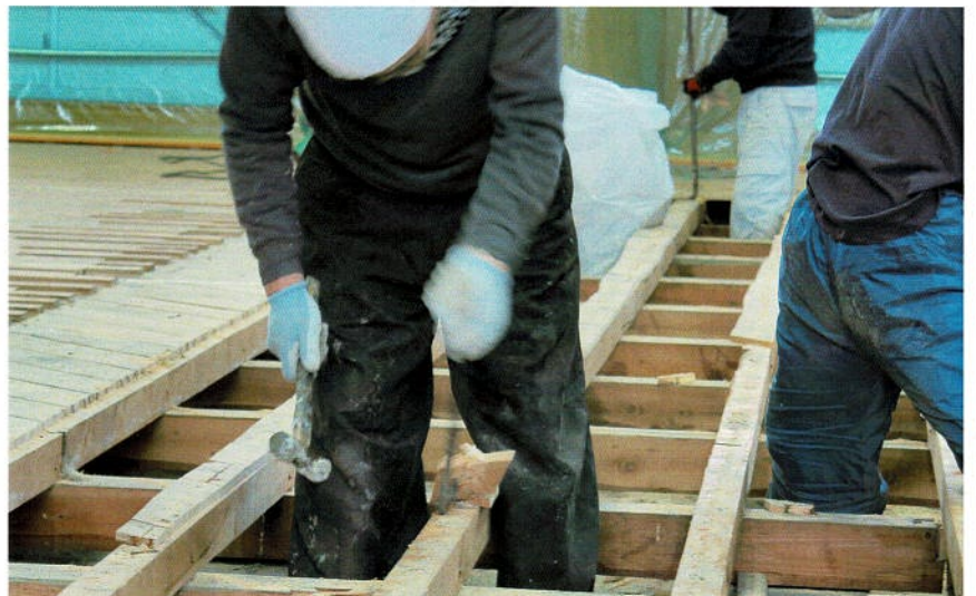
捨て張り板材の撤去
