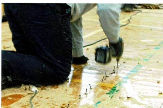
床材取り付けボルトは1本ずつ除去
