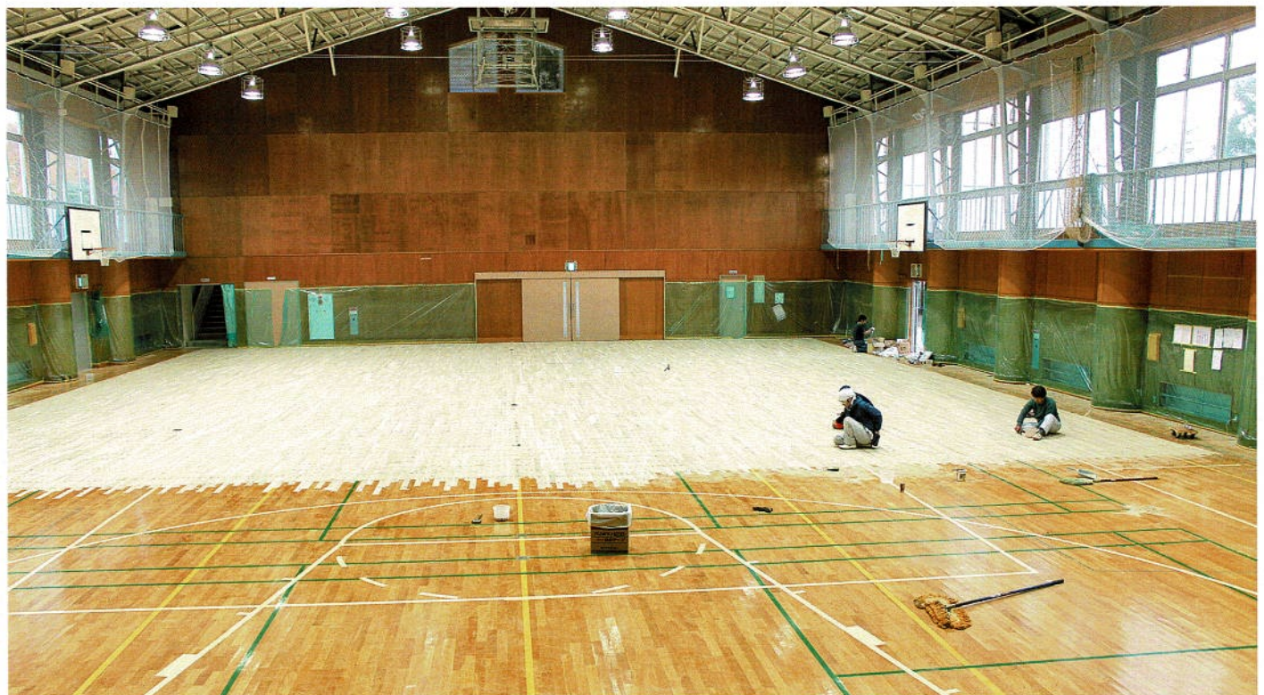
きれいに敷き詰められたフロア材
