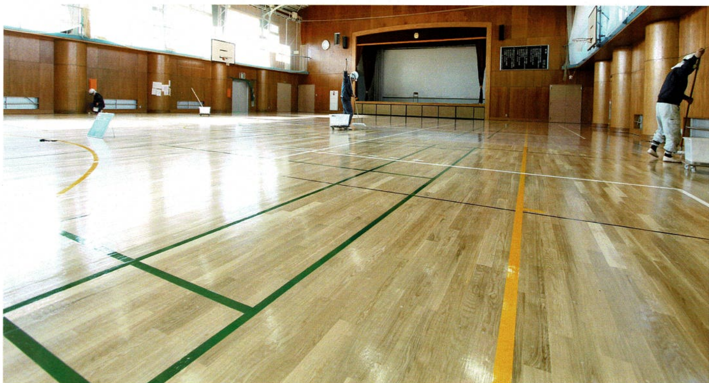
ライン完工。クリアコーティングをさらに施します
