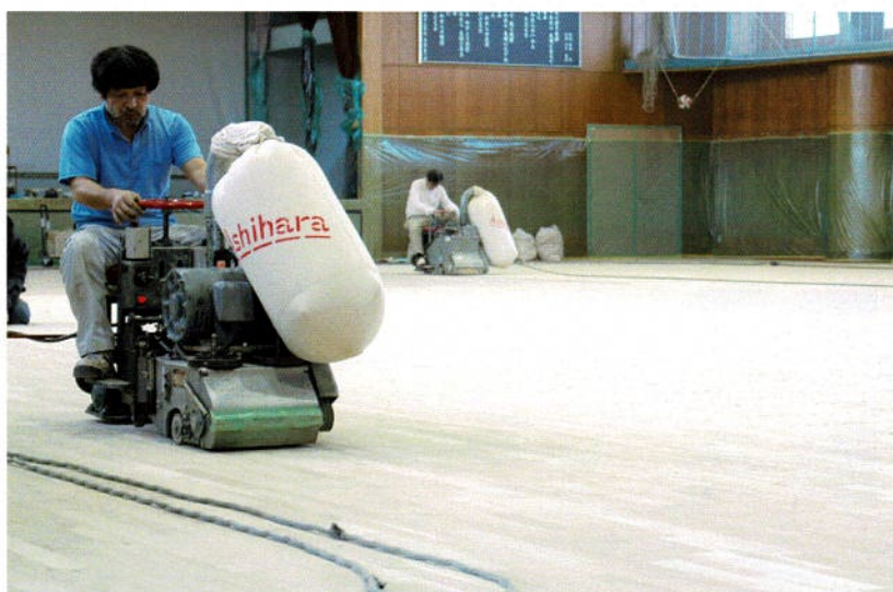
自走式のサンダー機で2回目のサンダー掛け
