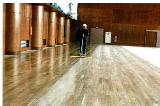
磨き研磨後、研磨粉を除去
