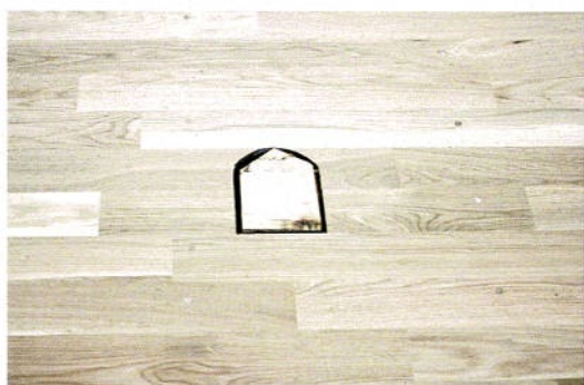
金具穴は仮駒を置いて研磨します
