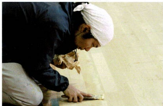
細部の間隙はウッドパテで処理
