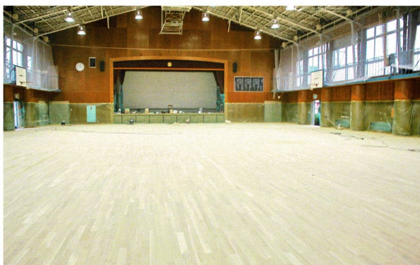
水性ポリウレタン樹脂塗料塗布前、粉塵吸引除去が終わったフロアー
