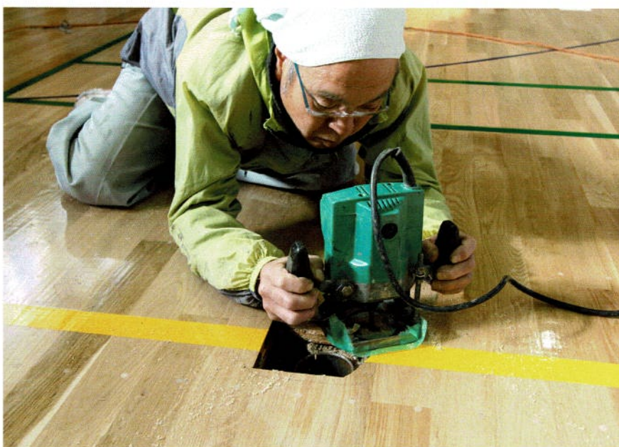
ルータで溝切り。熟練の技巧が光ります
