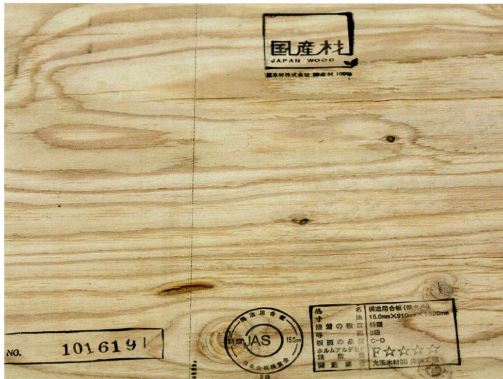
新規に張る床材下の構造用合板 (15mm厚 国産 低ホル / F ☆☆☆☆)
