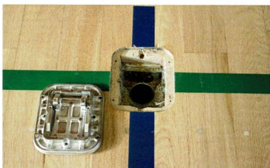
仕上がった床金具ホールとパネル
