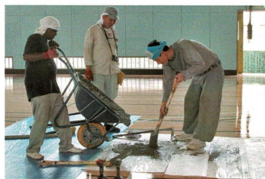
基礎部へ生コン注入
