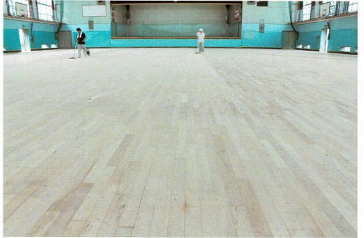
2回の研磨終了後、微細粉を丁寧に吸引除去
