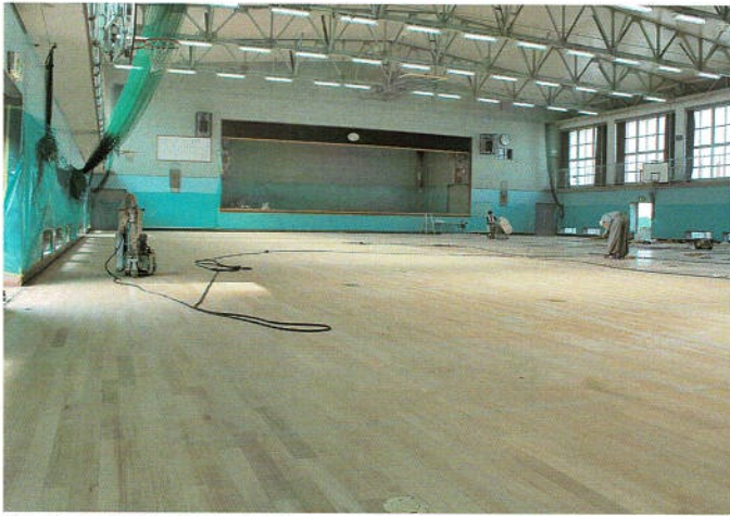
2回目の重ね研磨作業
