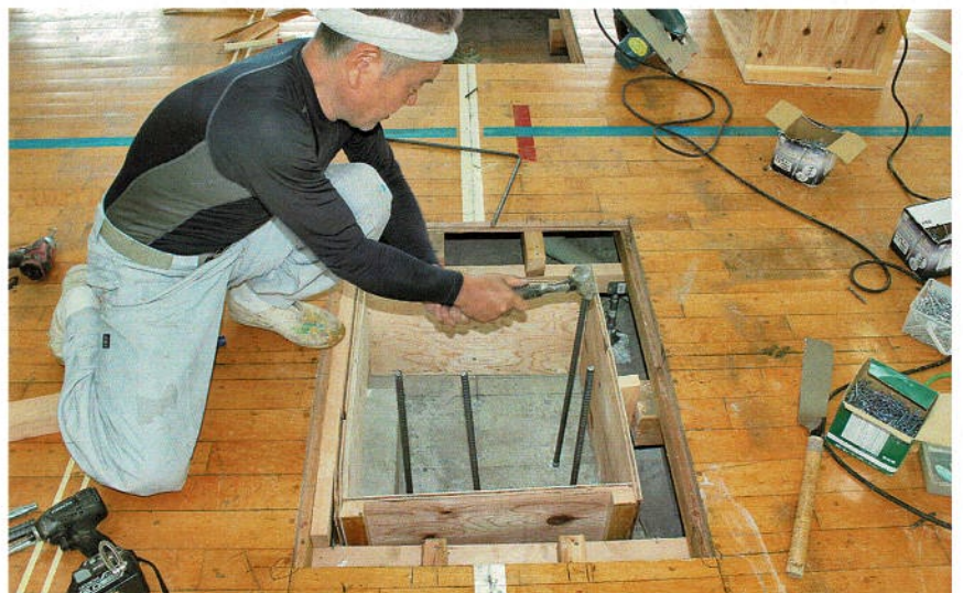
鉄筋アンカーの打ち込み
