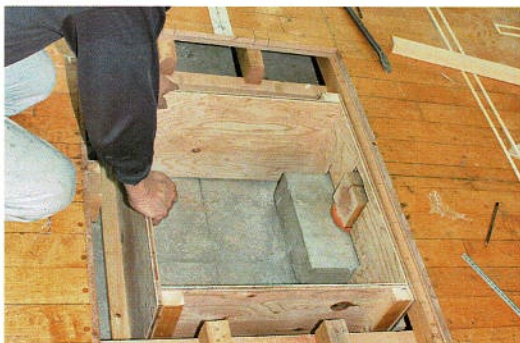
型枠の綿密なチェック
