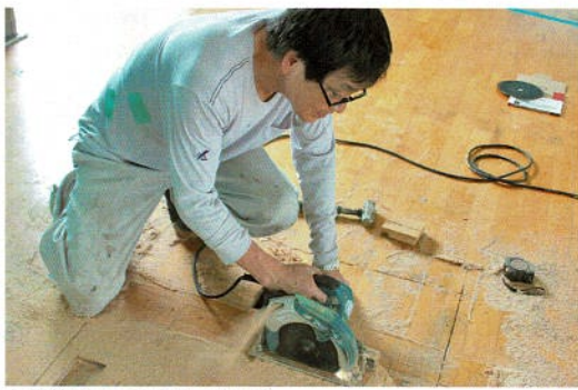
修繕箇所の開口作業
