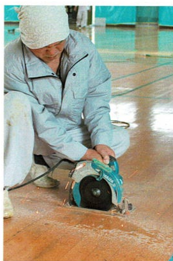
床材の剥離に着手
