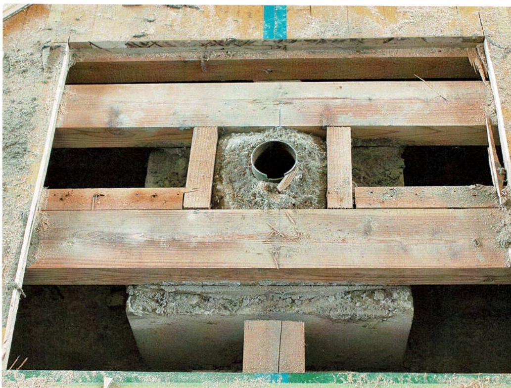
床材をはがしたグラつきのあるポールアンカー基礎の状態
