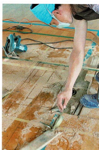
床材をはがしたグラつきのあるポールアンカー基礎の状態
