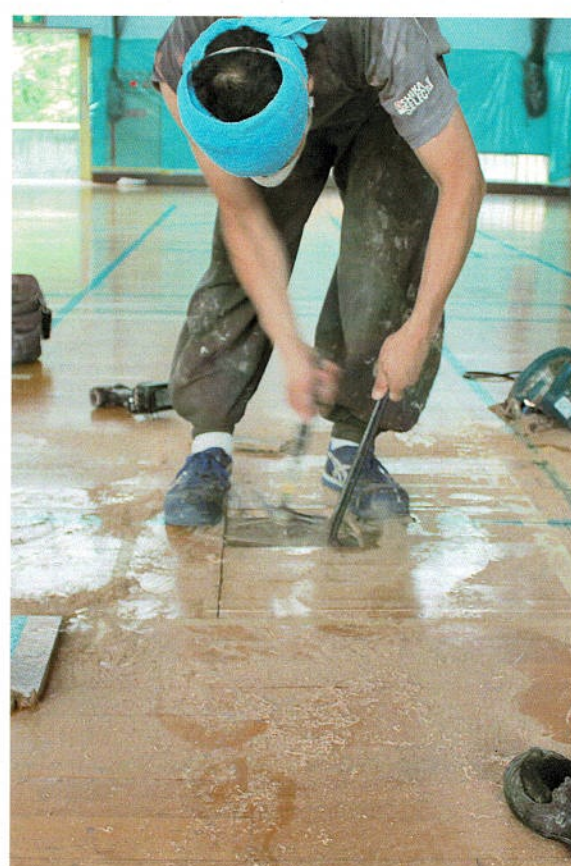
慎重な床材の剥離工程
