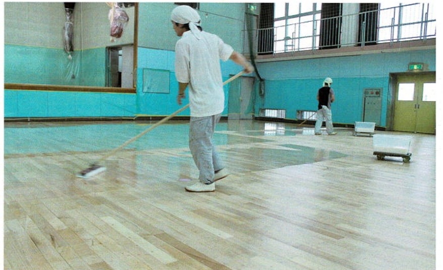
2回目のクリアワックス塗布。その後につや出し研磨します
