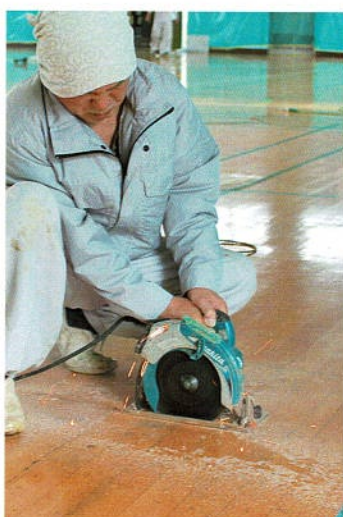
床材の剥離に着手
