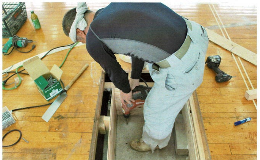
鉄筋アンカー設置用の穿孔作業
