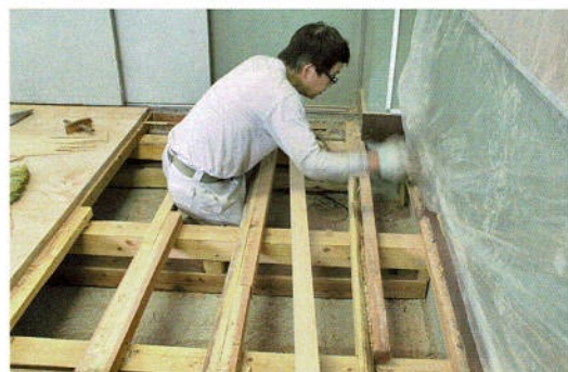
平行して昇降口の床補修
