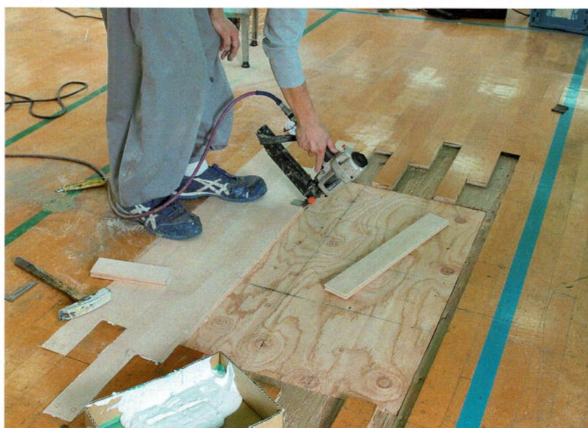
熟練の床材貼り込み作業。サネ合わせもピッタリ
