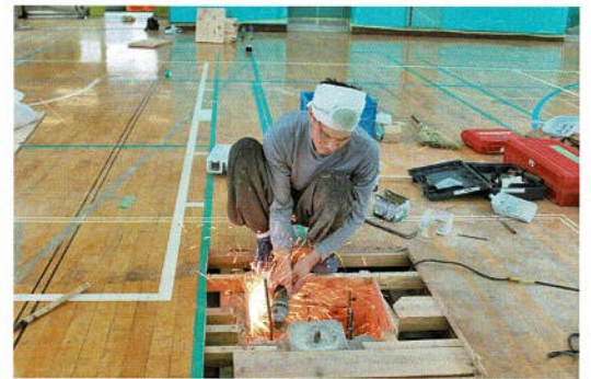
鉄筋を切断して高さを調節
