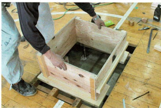
新しい基礎用の型枠 (仮合わせ)
