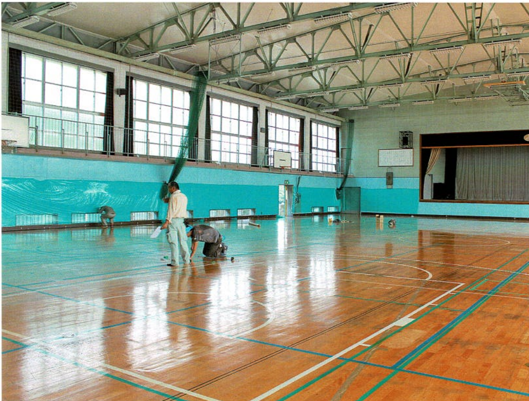
補修前点検で修繕箇所の入念なチェック
