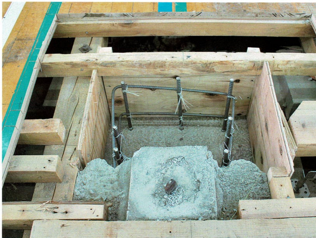
型枠設置完了後、開口部の閉鎖作業へ
