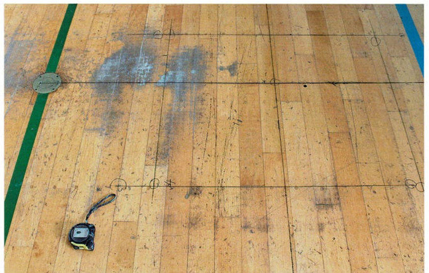
新規のボールアンカーの設置箇所の特定制量
