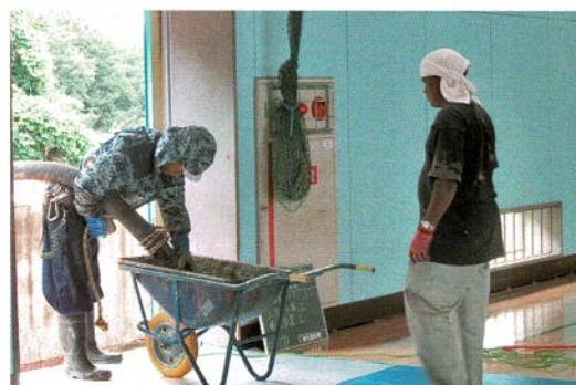
圧送車から生コン搬入
