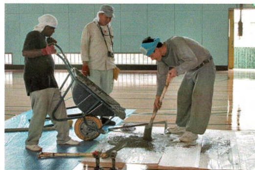
基礎部へ生コン注入
