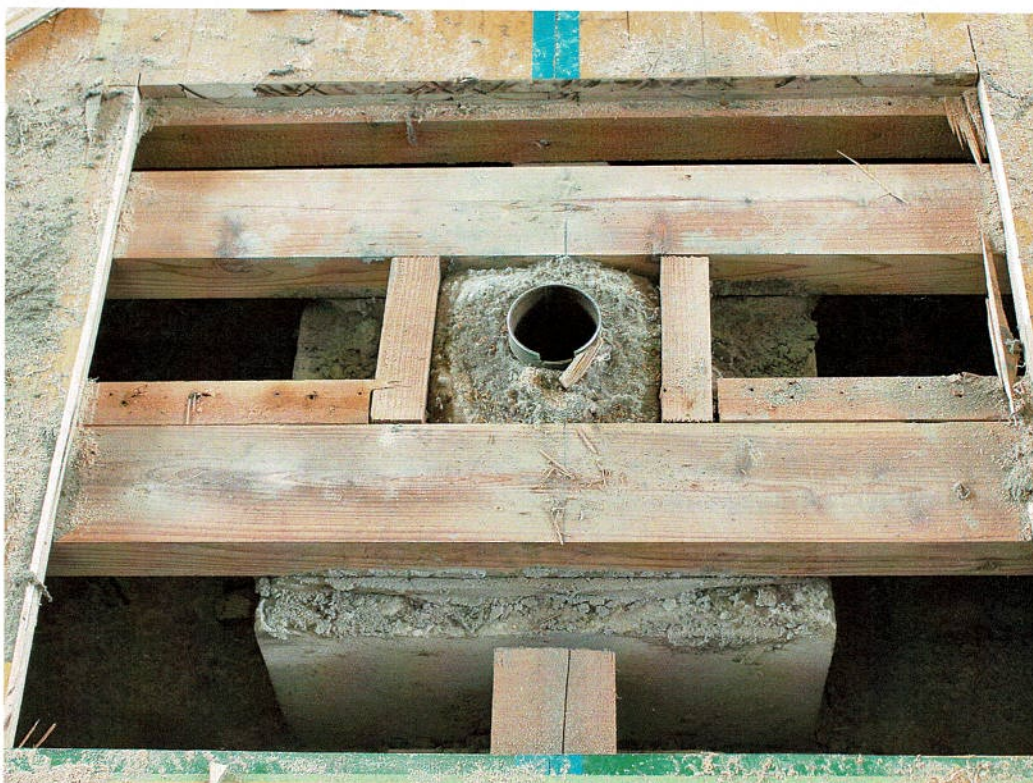
床材をはがしたグラつきのあるポールアンカー基礎の状態
