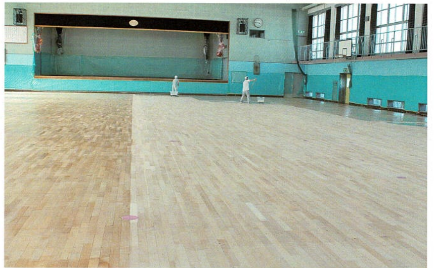
特殊樹脂刷毛ですべて手作業で塗布
