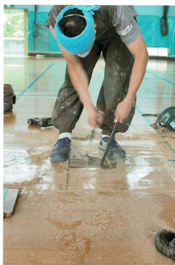
慎重な床材の剥離工程
