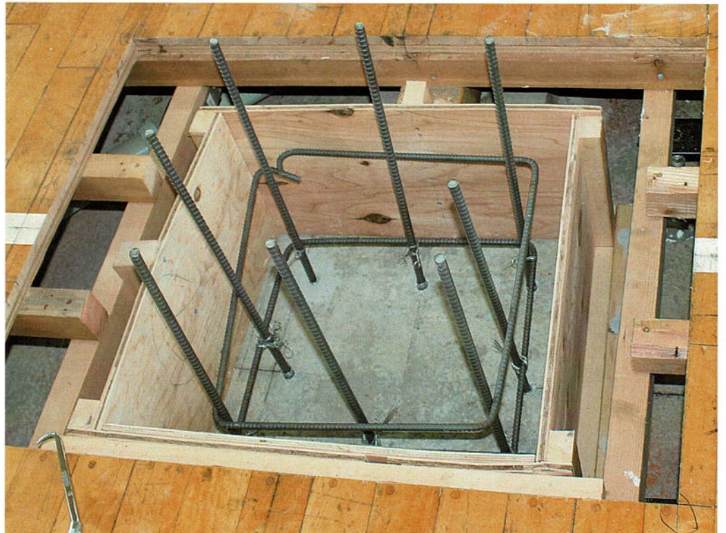
型枠を再度設置して生コン注入に備える
