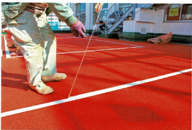
乾燥後マスキングテープを撤去
