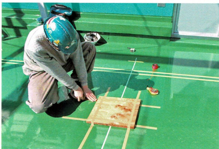
円弧ライン用のセンターポイント用の養生セット作業
