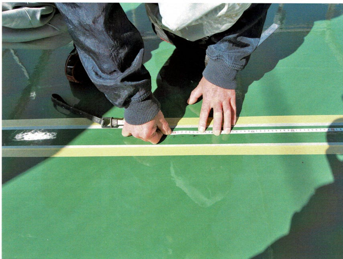
ライン取りしたマスキングテープの精度を再確認
