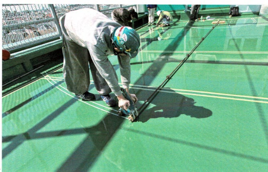
大口径サークルラインのマスクング作業
