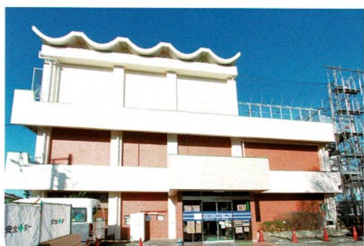
この建築物の屋上が施工場所です
