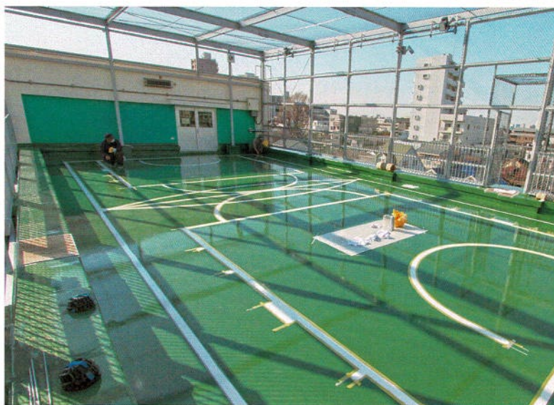
乾燥確認後、マス킹テープの剥離作業へ
