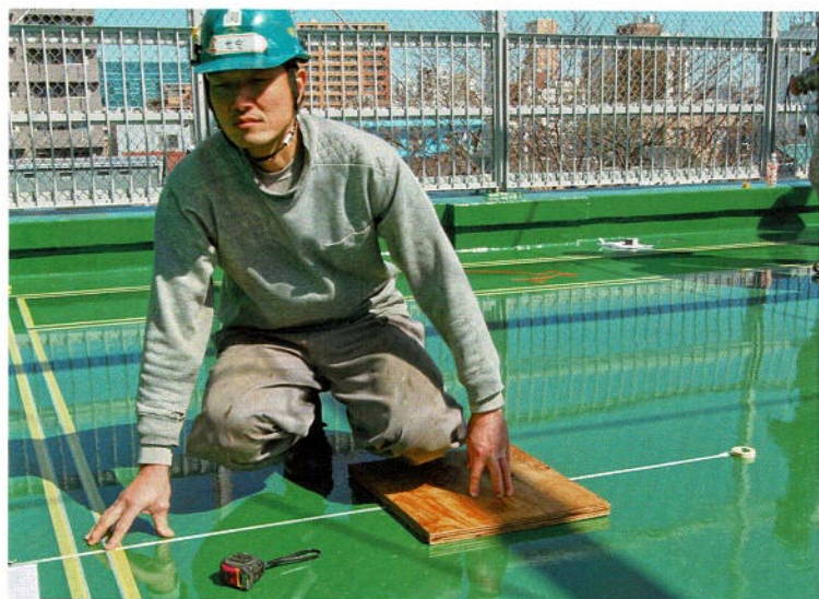
円弧ライン用のセンターポイント用の養生セット作業
