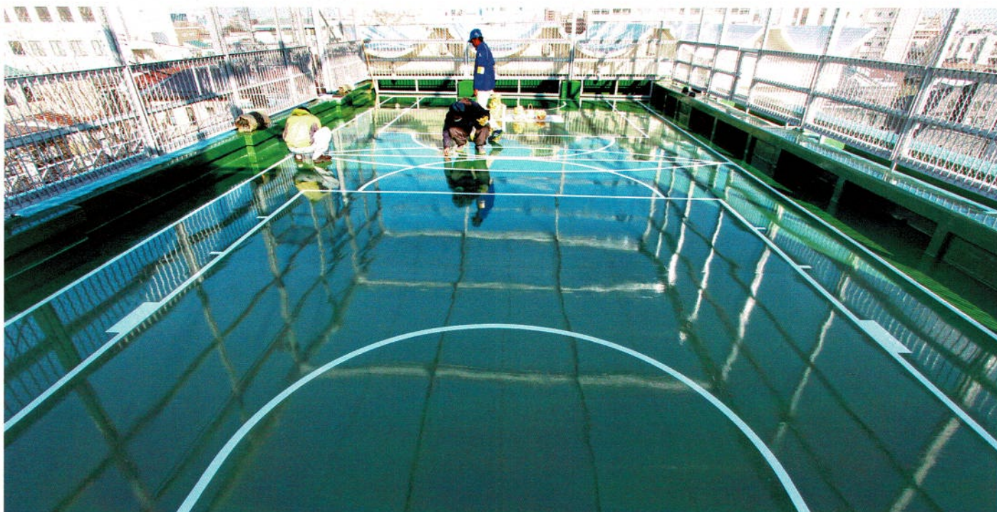
施工完了直前の目視チェック
