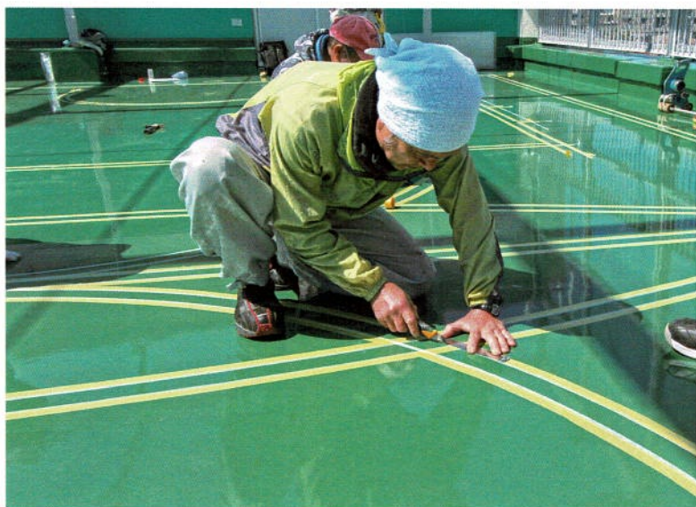
交差するマス킹テープの順位に合わせたセッティング作業
