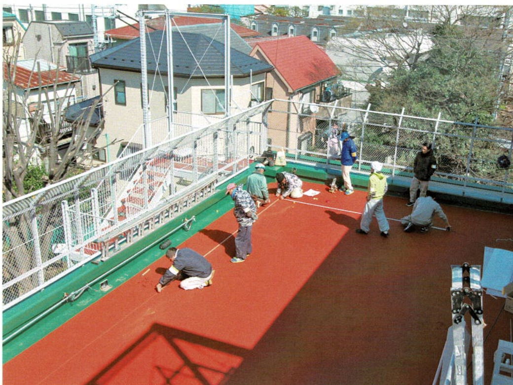
第2現場の施工開始
