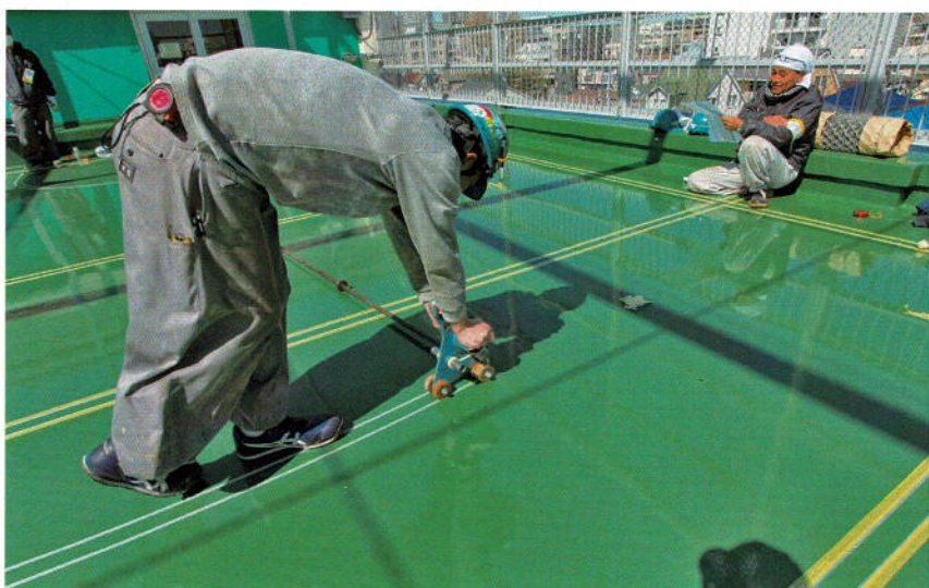
同 大口径サークルラインのマスクング作業
