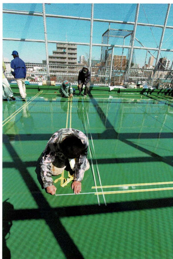
平行してライン幅に合わせてマスキング作業
