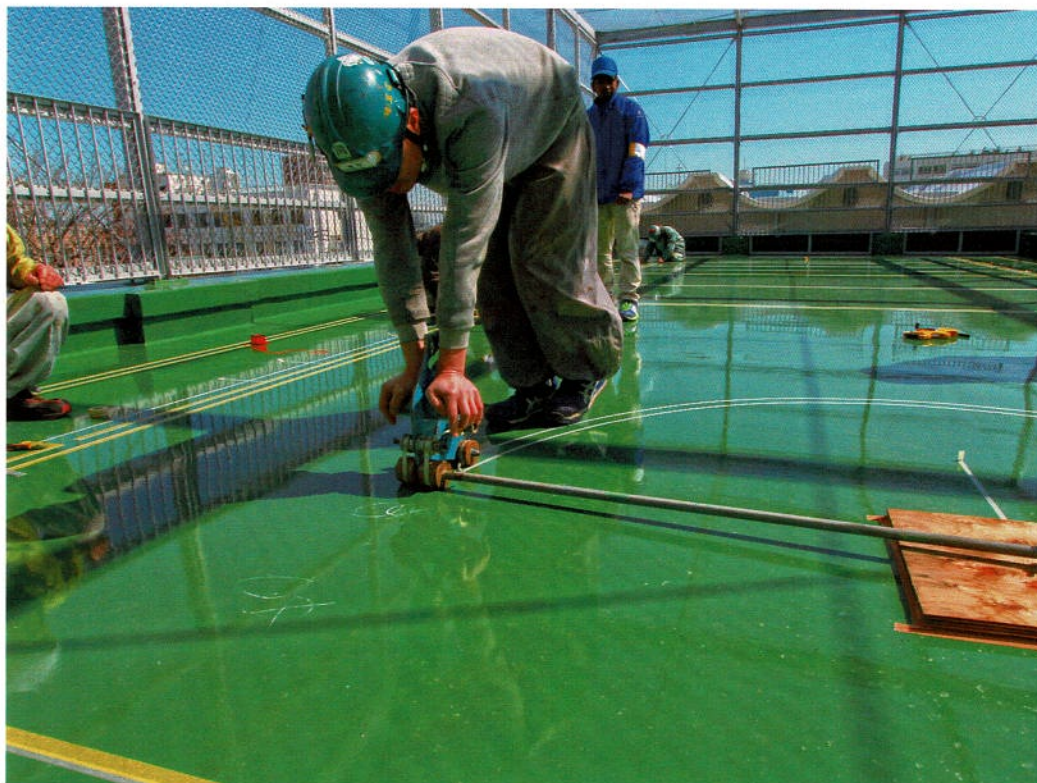
小径サークルラインのマスクング作業
