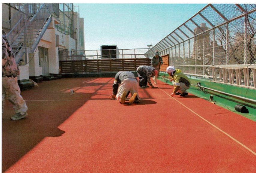
2 剤硬化型のライン塗装用 ウレタン弾性塗料
