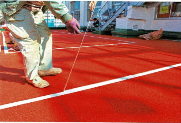
乾燥後マスキングテープを撤去
