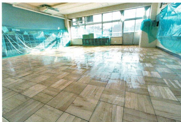
1回目の塗布完了
