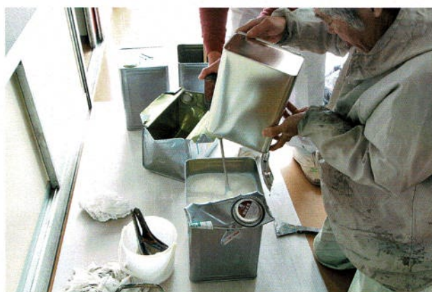
3回目、仕上げ用のウレタンクリアー塗料の合液
