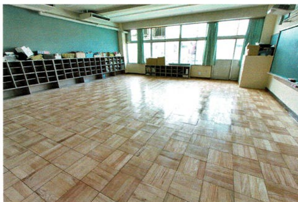
2回目の塗布完了
