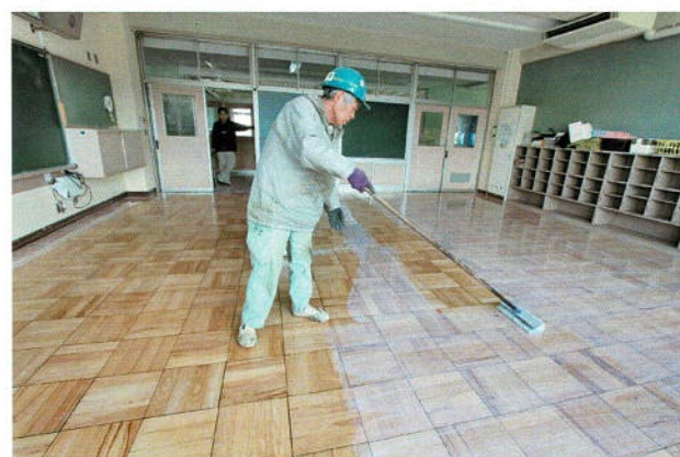
ムラなく丁寧な仕上げ塗布
