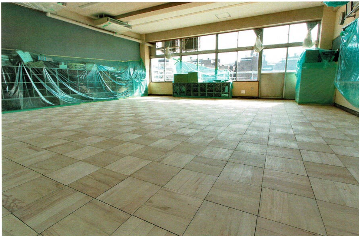
塗装前研磨が完了した床
