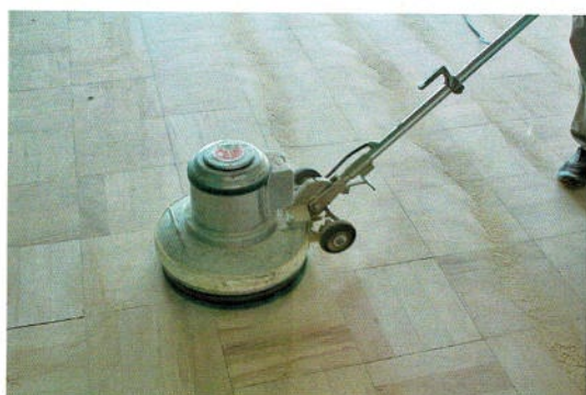
2回の研磨後、ポリッシャーによる仕上げ研磨で床材表面を丁寧に鏡面に仕上げています
