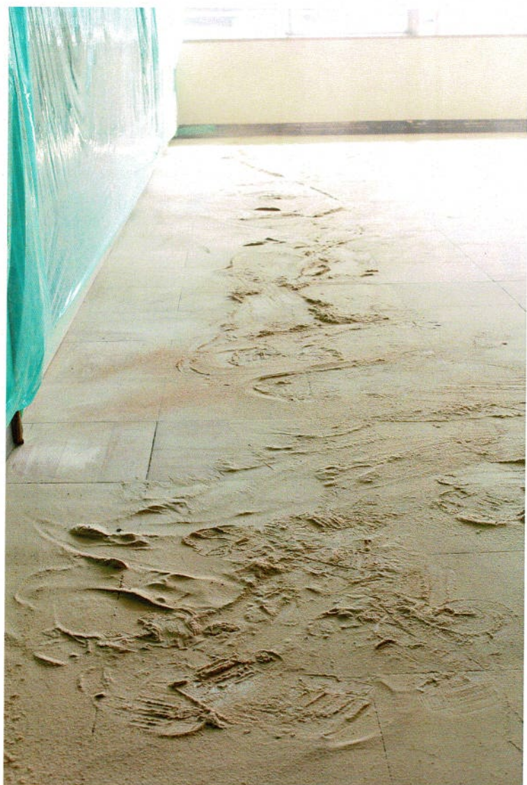
仕上げ研磨後にでる研磨屑
