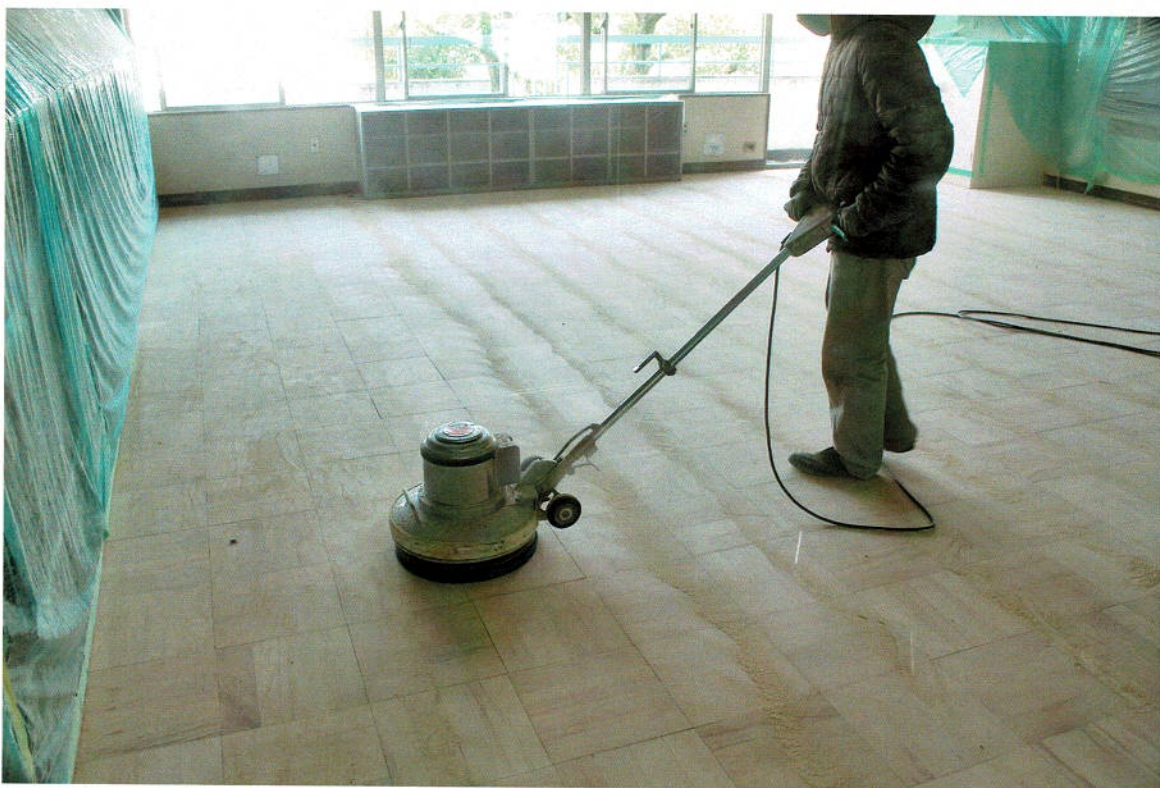
2回の研磨後、ポリッシャーによる仕上げ研磨で床材表面を丁寧に鏡面に仕上げています
