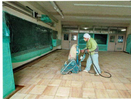
サンダー機で研磨できないコーナーや壁際はグラインダーで研磨します
