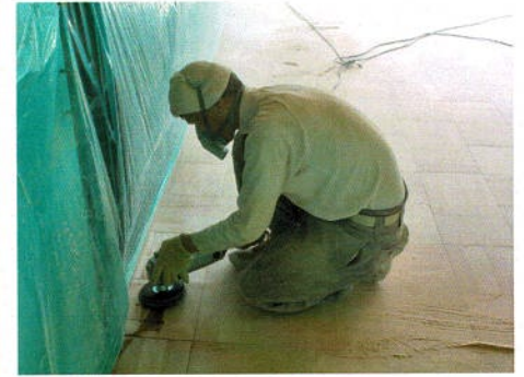
平滑に研磨する熟練の技
