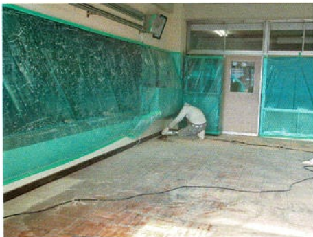
サンダー機で研磨できないコーナーや壁際はグラインダーで研磨します
