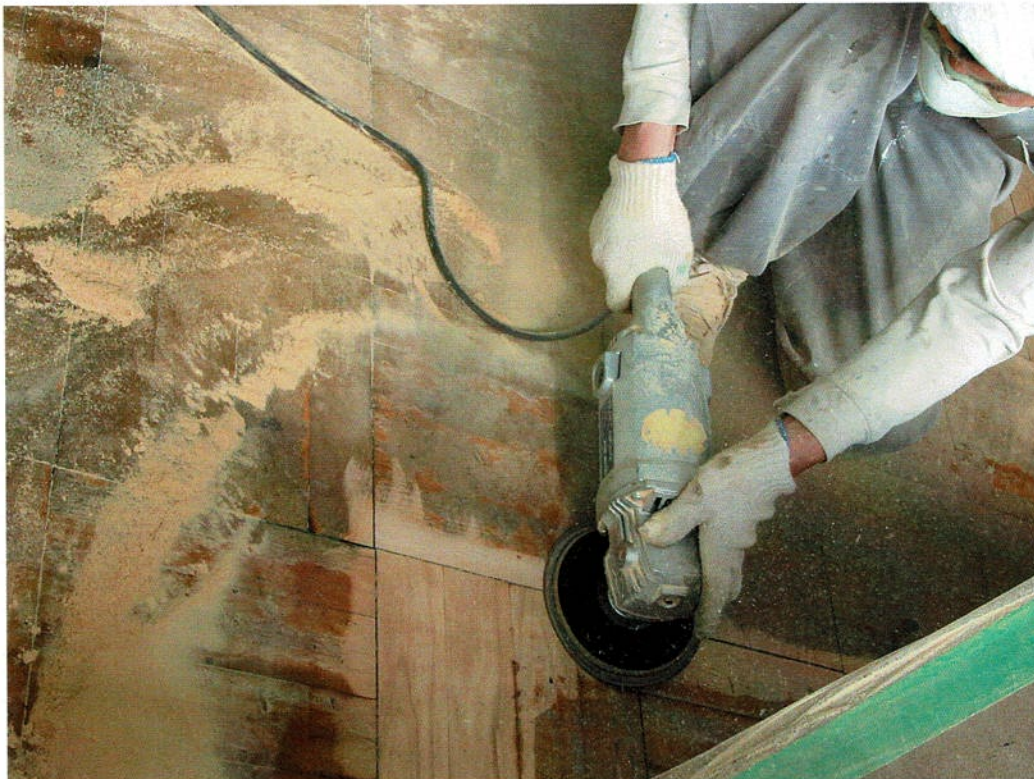
サンダー機で研磨できないコーナーや壁際はグラインダーで研磨します
