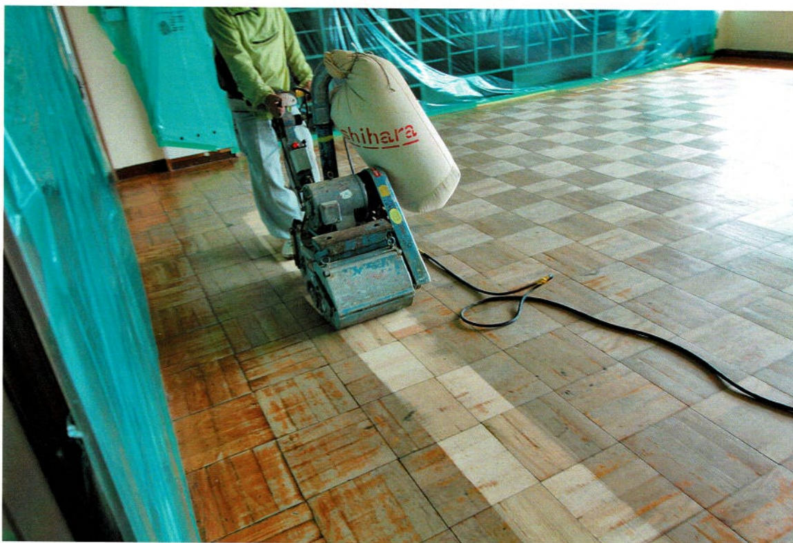
養生のすんだ教室からサンダー機による 1 回目の研磨に入ります
