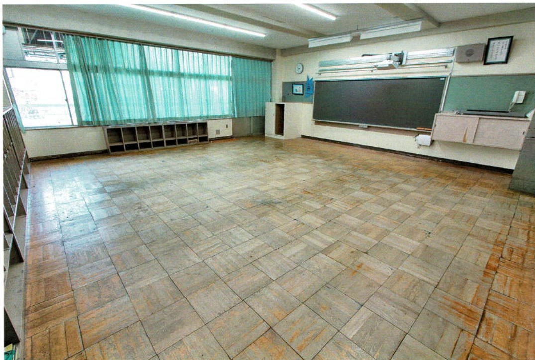
補修前の教室
