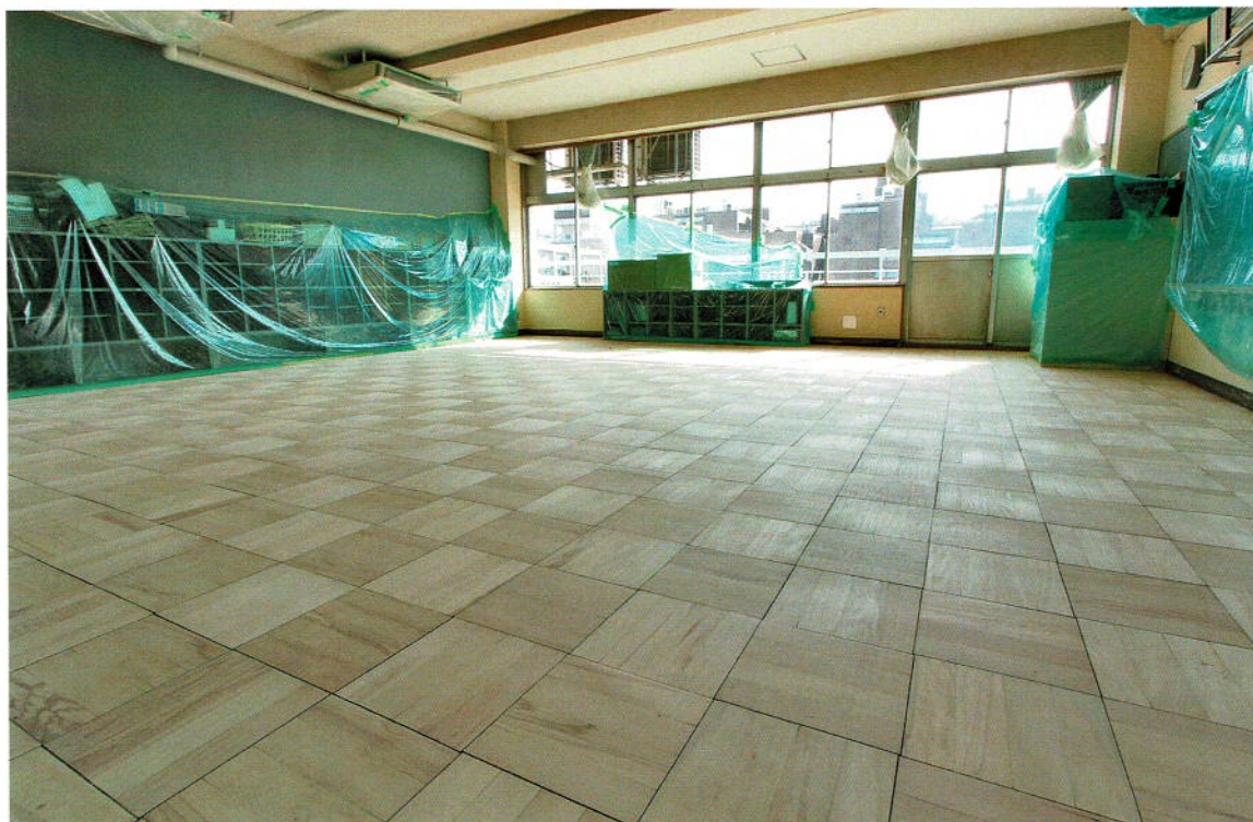
塗装前研磨が完了した床
