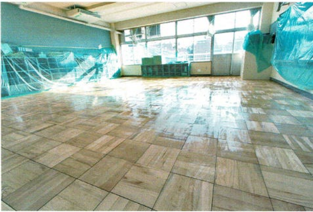
1 回目の塗布完了
