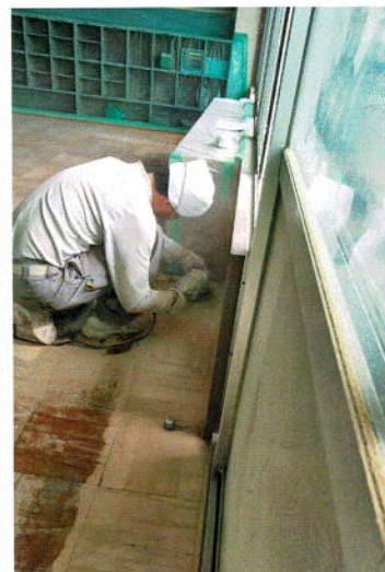
平滑に研磨する熟練の技
