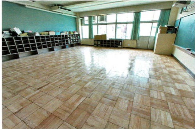
2 回目の塗布完了
